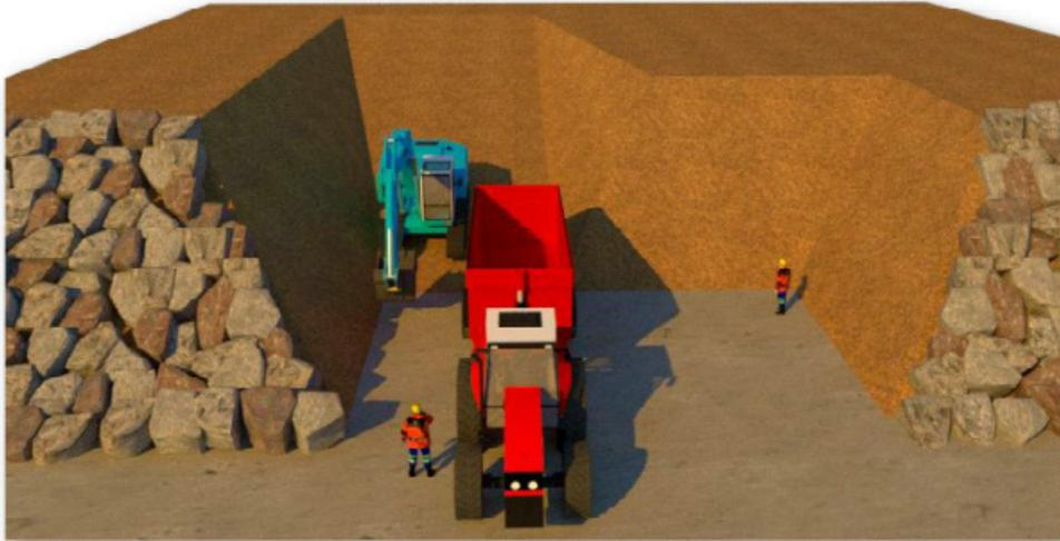
Schémas 3D n°1 : Réalisation de la rampe d'accès (Entreprise MARC)
